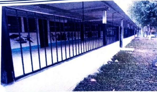
Foto 1: se cambio el techo con laminas troqueladas
