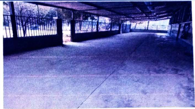
Foto 2: se cambio el piso con entortado de cemento y se colocaron barandales con hierro entorchado.
