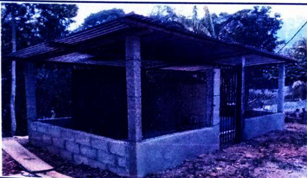
Foto 5: circulacion con tres hiladas de block del lugar de los cisternas de agua para evitar el desperdicio del vital liquido.
