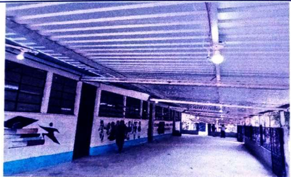
Foto 3: se mejoro el sistema electrico colocando cableado y bombillas nuevas.
