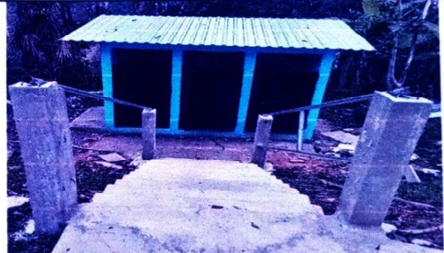
Foto 4: se cambio el techo de los sanitarios, se pinto y se colocaron gradas con pasamanos de tubo galvanizado.
